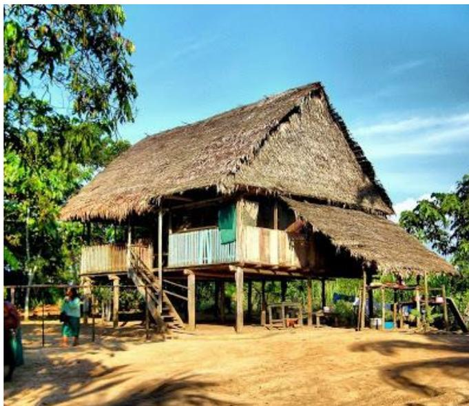
Como se puede observar en este caso, las viviendas no están apoyadas directamente sobre el suelo, debido a que durante la temporada de lluvias la zona se inunda y el agua puede alcanzar hasta 1.00 m de altura.
